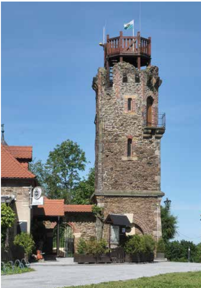
Blick auf den Kupferbergturm, Foto: Steffen Peschel
