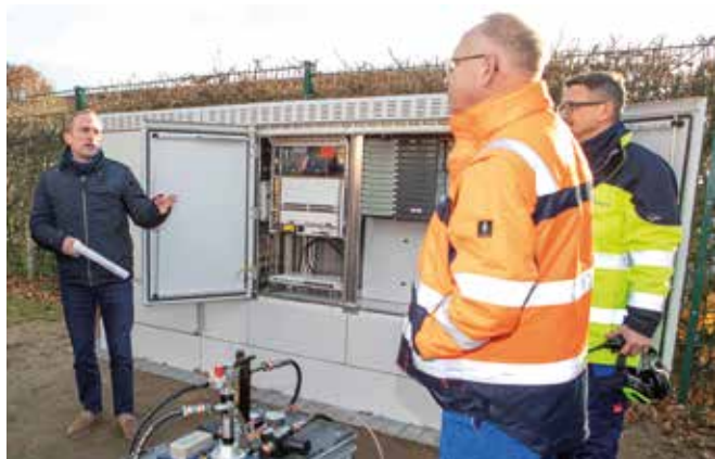
Auf den Breitband-Baustellen geht es weiter voran. ENSO NETZ-Regionalbereichsleiter Tilo Kadner (li.) ist guter Dinge, mit Weßnitz schon bald den dritten Ortsteil schalten zu können. Foto: ENSO NETZ/Lutz Weidler
